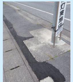
利保町の歩道補修
