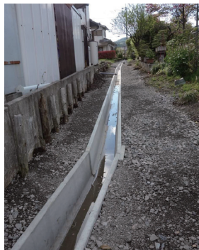
菅田町の排水路
