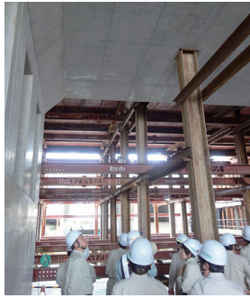
鹿島山下通りアンダーパス
