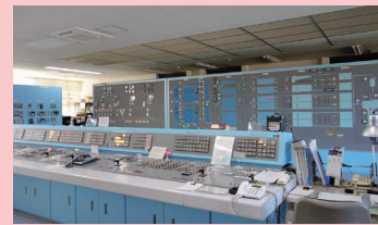
水処理センター
